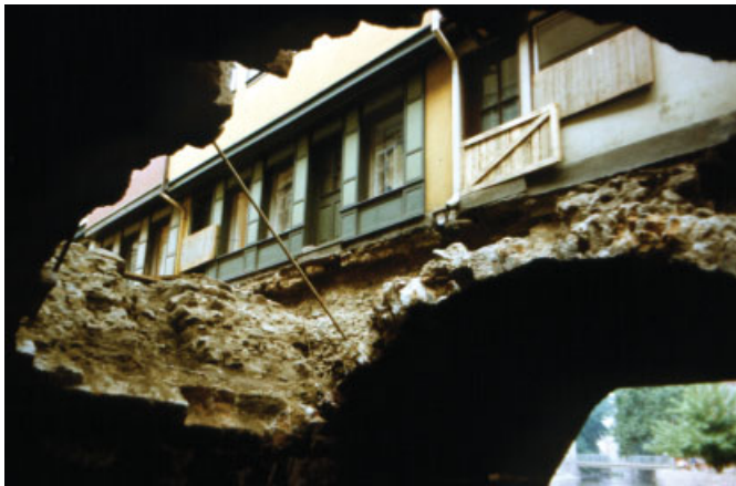
Bild 12. Blick von der Flusssohle des Breitstroms durch die Gewölbekonstruktion auf die Bebauung der Krämerbrücke Fig. 12. View of the Breitstrom river bed through the arches to the Krämer Bridge construction
