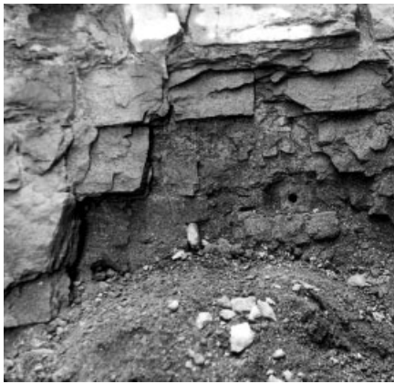
Bild 7. Natursteingewölbe mit entgegen der Beanspruchungsrichtung eingebauten Quadersteinen
