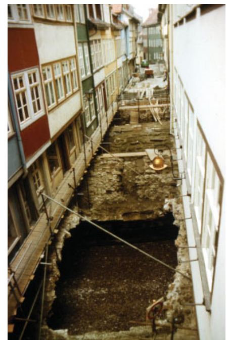
Bild 11. Freigelegte und abgebrochene Gewölbekonstruktionen Fig. 11. Uncovered and crumbling arches
