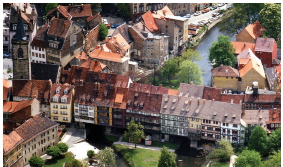
Bild 14. Kulturdenkmal Krämerbrücke Fig. 14. The Krämer Bridge – a cultural monument
