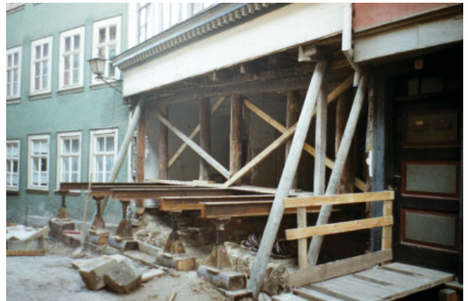
Bild 13. Unterfangung der Hausvorderfront Krämerbrücke Nr. 3 Fig. 13. Underpinning of the facade of Krämer Bridge house no. 3
